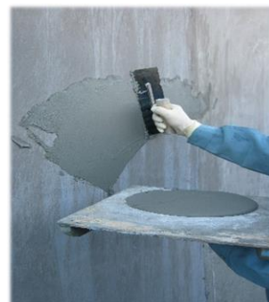
施工状況(コテ塗り)
