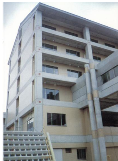
施工例(RC打放し部)
