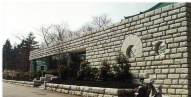
施工例(RC打放し部)
