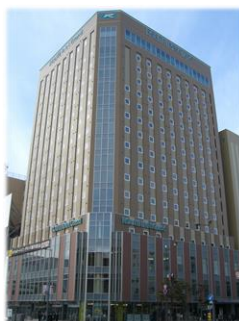
ST工法（宿泊施設 新築）
