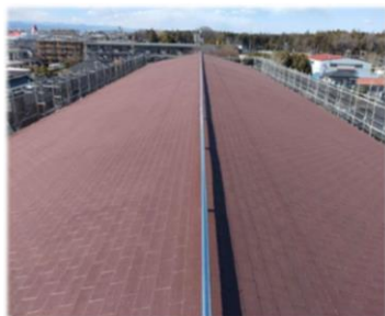
SQ-AS工法施工例 (既存:アスファルトシングル葺き屋根)
