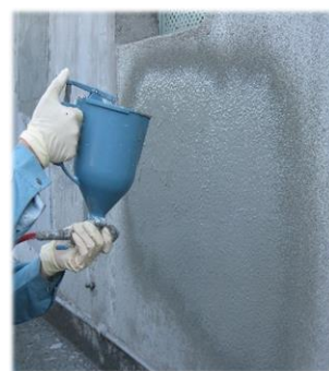
施工状況(吹付け)
