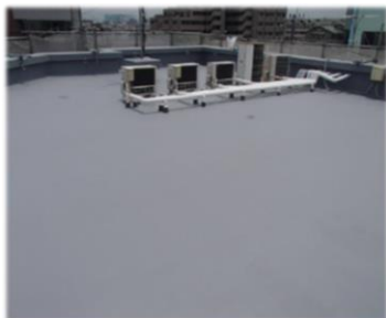
SQ-M工法施工例 (既存:露出アスファルト防水)
