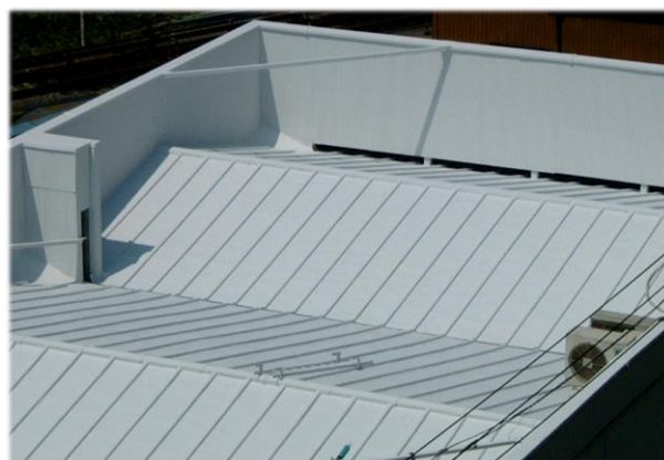
施工例(瓦棒屋根)
