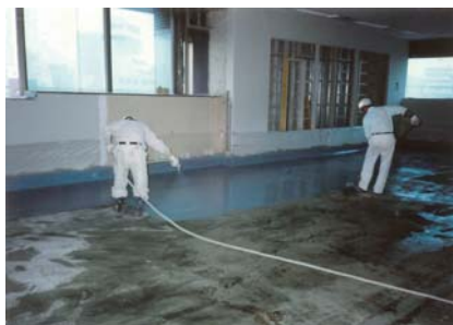
中塗材吹付け
