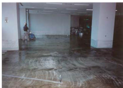
プライマー塗布
