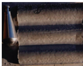
アロンQDスレート施工
