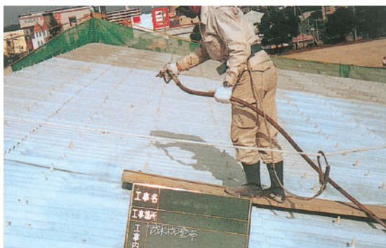
中塗材吹付け
