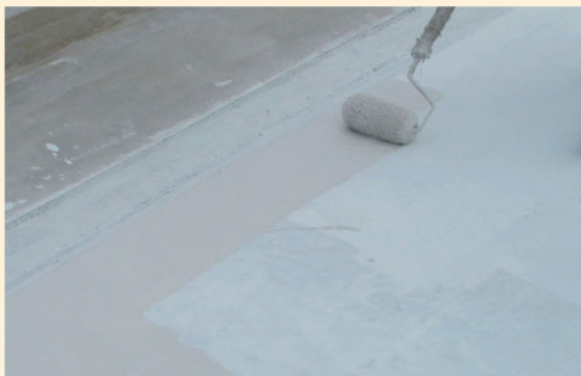
ローラーでの施工(2〜3回塗り)
