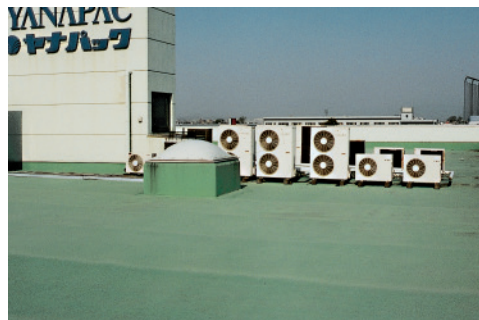
SQ-S 施工後、16年経過後の状況
