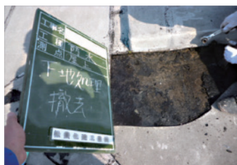
下地処理(ふくれ部撤去)
