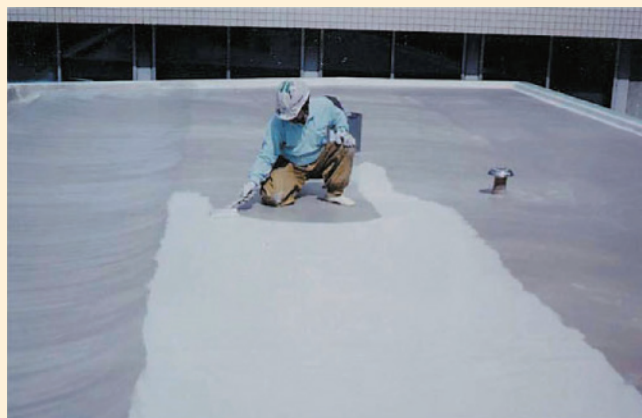
左官刷毛での施工(2回塗り)
