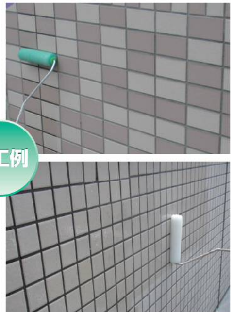
クリアウオール CP-100 [下塗用] 塗布状況
