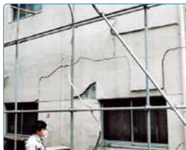
アロンウオール塗布外壁の状況
