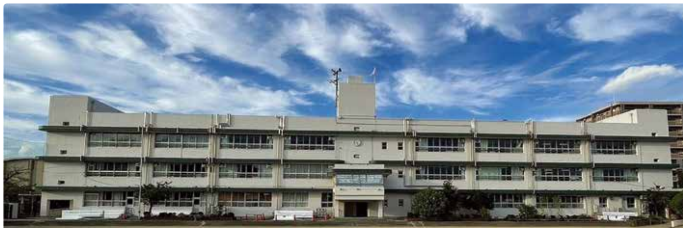
▲ 畑田小学校南棟校舎(大阪府) ▼
