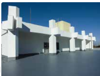
◀ 某大学屋上ペイントハウス(愛知県) ▼
