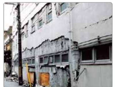
一般的な外壁の状況
