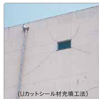
施工後数年経過
